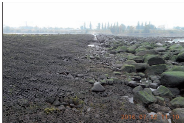
Fot. 4. Próg przy zatrzymanym przepływie.
