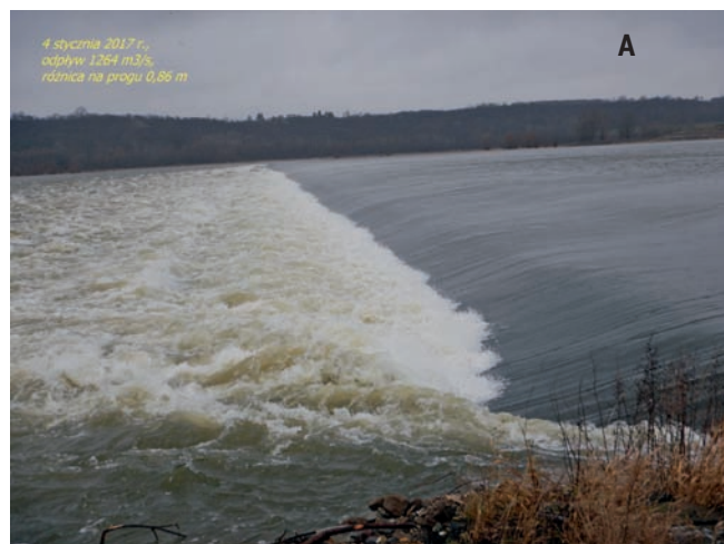
Fot. 2. Lewy (A) i prawy (B) koniec progu 4 stycznia 2016 r., przy odpływie 1264 m 3 /s i różnicy na progu 0,86 m.
