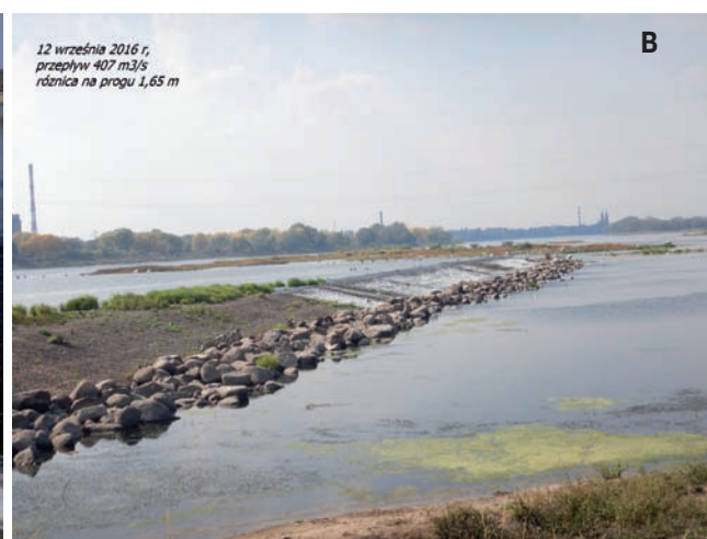
Fot. 1. Lewy (A) i prawy (B) koniec progu 12 września 2016 r., przy odpływie 407 m 3 /s i różnicy na progu 1,65 m.
